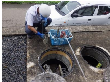
浄化槽法定検査の様子
